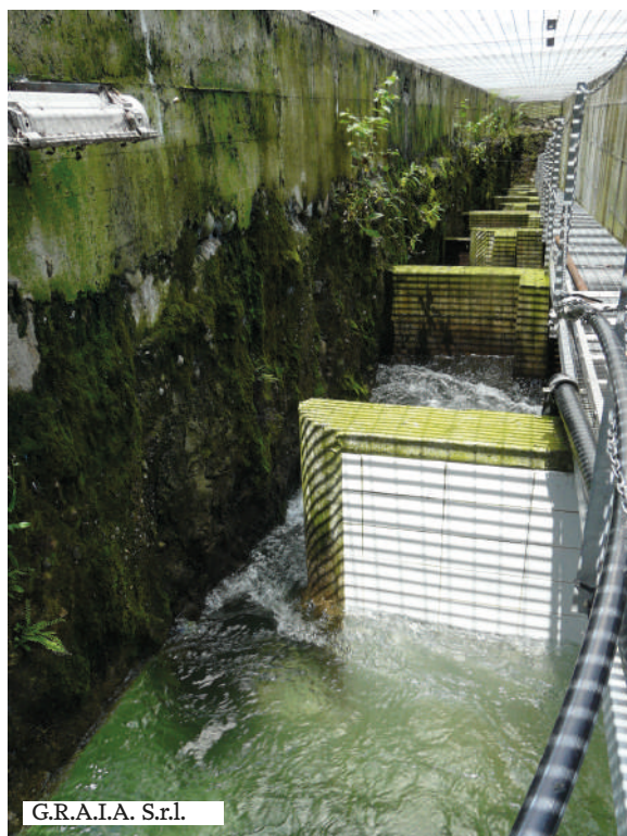
Particolare del passaggio per pesci di Lavena Ponte Tresa (VA) sul fiume Tresa
