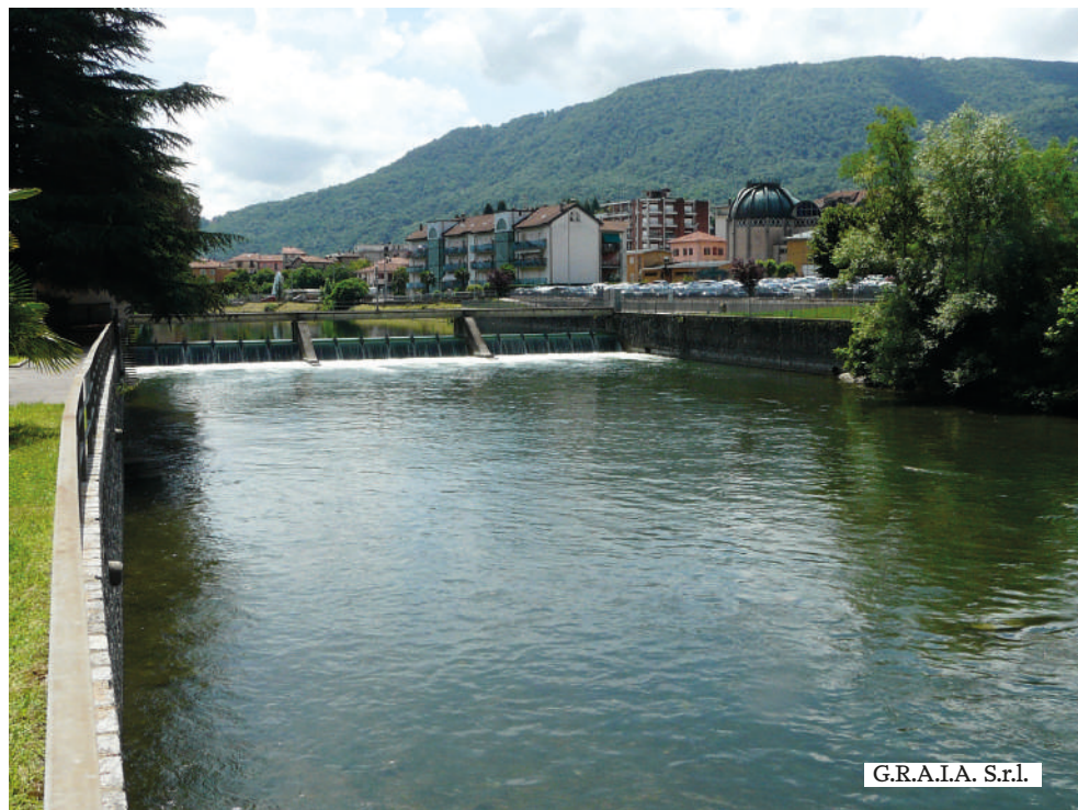
Sbarramento sul fiume Tresa e Lavena Ponte Tresa (VA)
