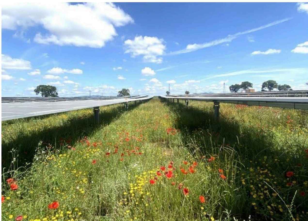
Figura 14 - Veduta post-costruzione dell'impianto fotovoltaico di Montalto di Castro, con evidenza della ripresa della vegetazione erbacea e della ricostituzione della copertura verde tra i moduli
